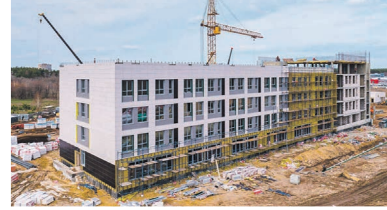
Строительство школы на ул. Остужева идёт полным ходом. Её открытие планируется в сентябре 2023 года
