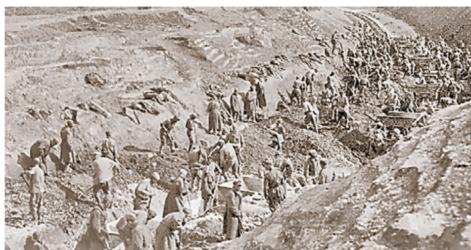
Советские военнопленные на строительстве «берлинки» (Гнилое — Евдаково). Осень 1942 года
