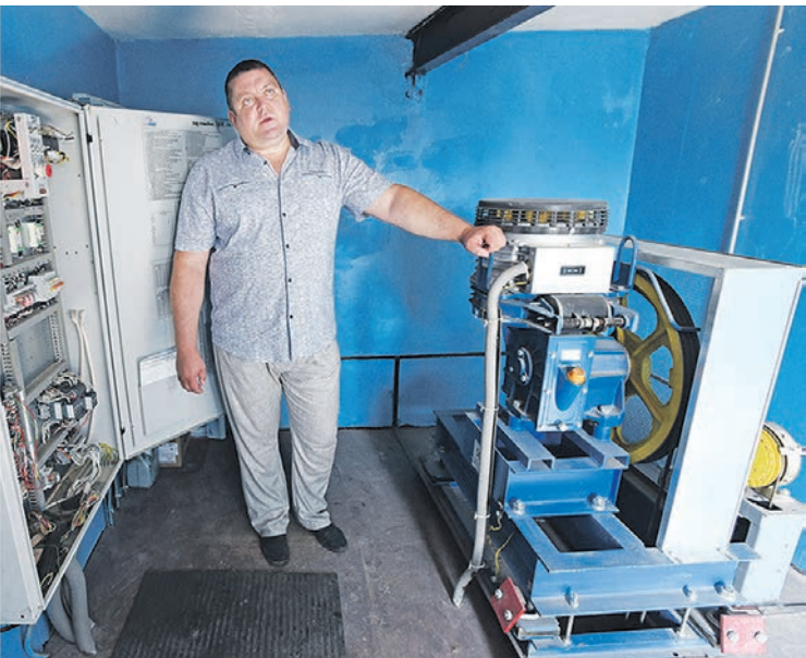
Подъёмный механизм лифта снабжён несколькими тросами, каждый из которых способен выдержать вес в несколько тонн
